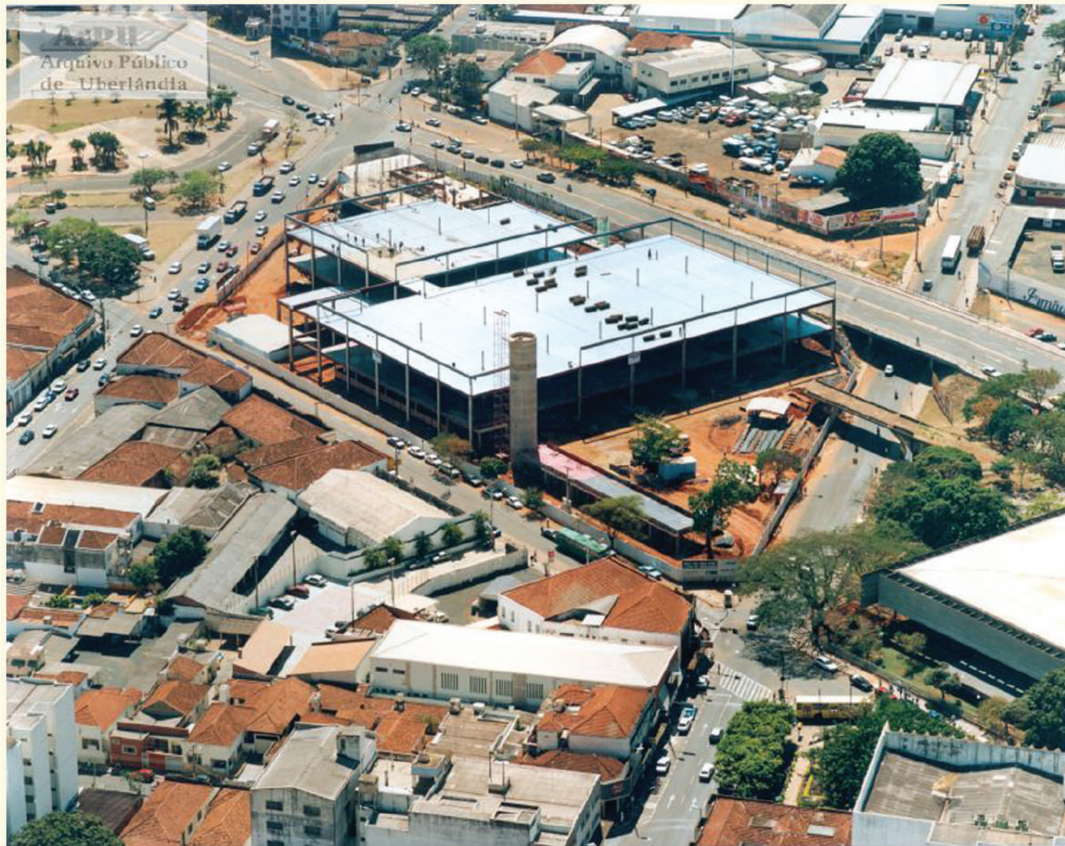
Vista parcial da cidade. Construção do Terminal Central (terminal de transporte coletivo urbano).Área central. Centro.
