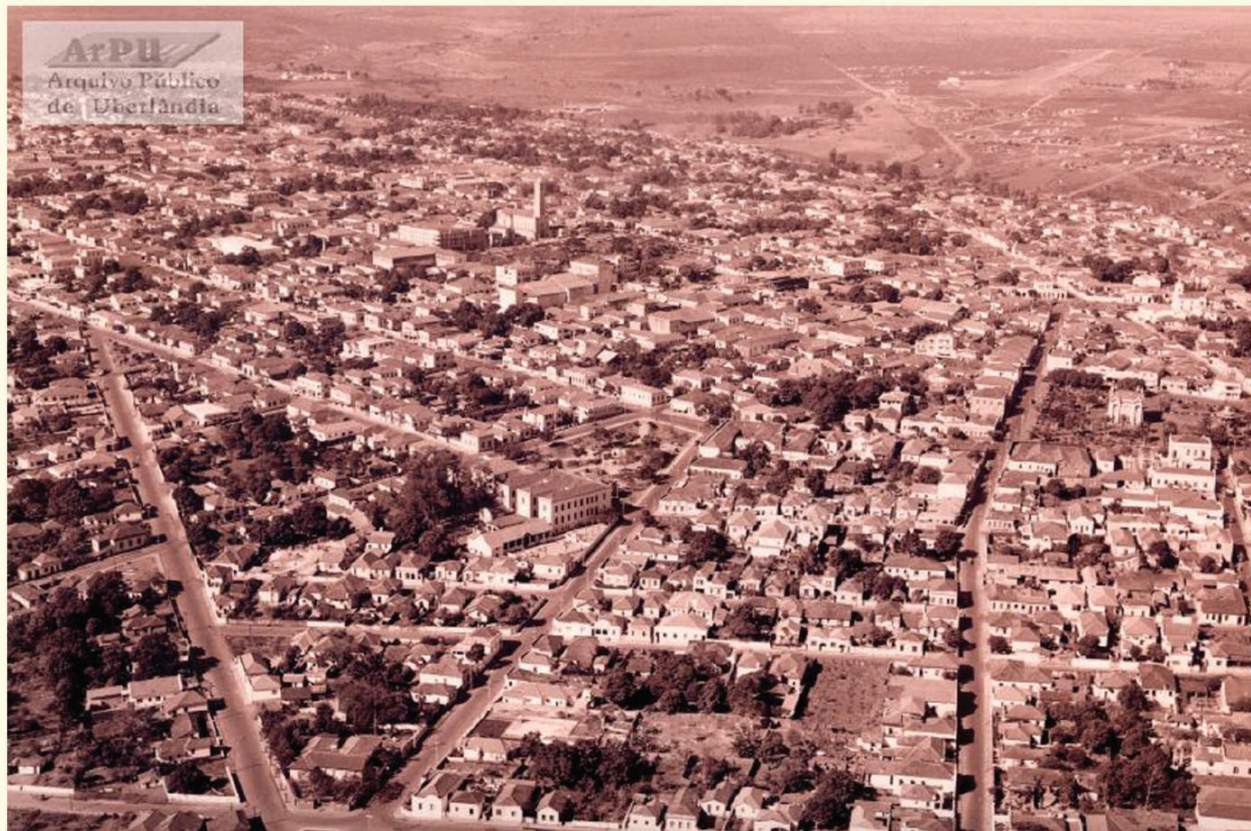
Vista parcial da cidade. A direita bairro Fundinho e a esquerda área central. Década de 1940/50
