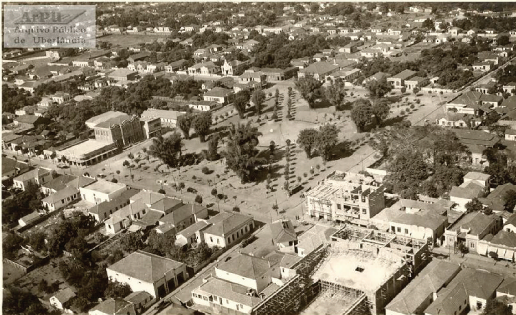
Vista parcial da cidade, vendo-se no centro a praça da República (dos Bambus), atual praça Tubal Vilela e todo o seu entorno. Lado esquerdo na esquina da av. Afonso Pena com a rua Duque de Caxias o Armazéns Colombo ao lado o prédio do 2º Fórum da cidade. Lado direito vista do alto a construção do prédio da Drogasil e bem na esquina da rua Olegário Maciel com a av. Afonso Pena a construção do prédio do Abdulmassih. Década de 1930
